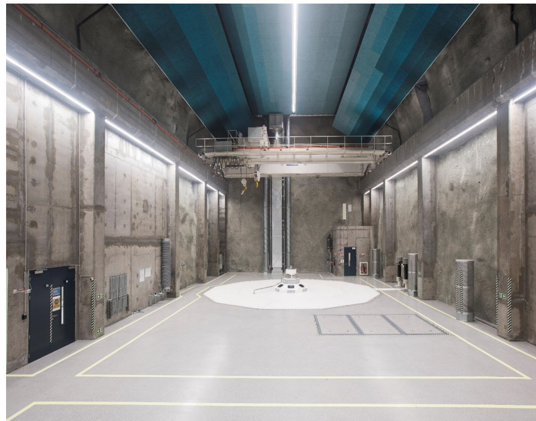
Búrfellsstöð II – Gangsett 2018
