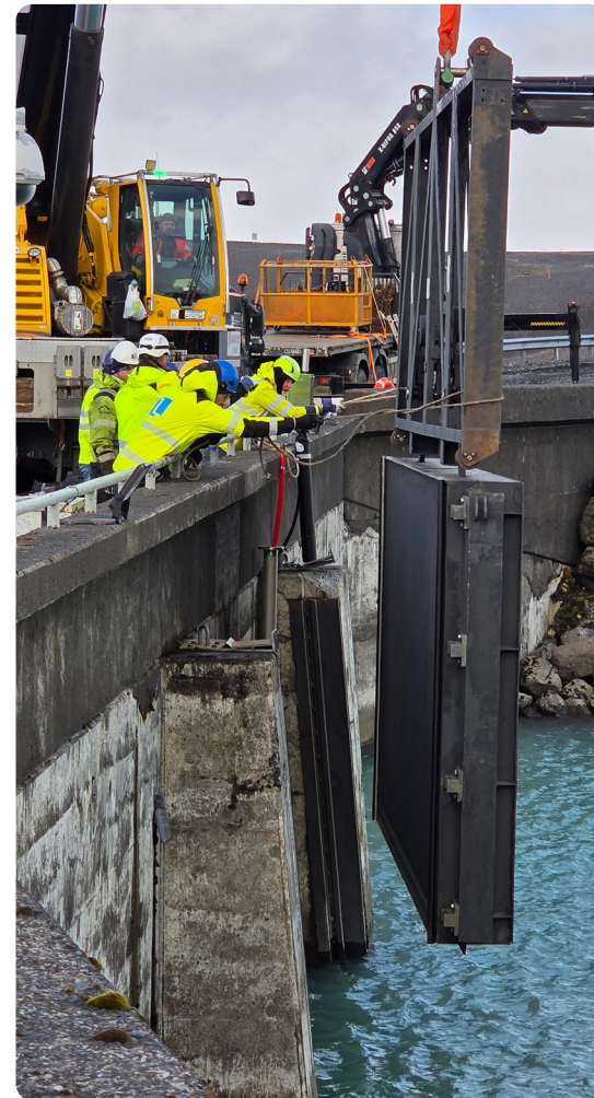
Vinnulokur settar niður í Þórislokum.
