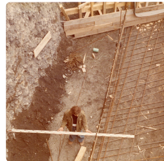
Framkvæmdir við Sigöldu í júlí 1976.
