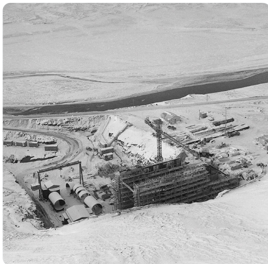
Búrfellsvirkjun í smíðum árið 1967. Mynd: Ólafur K. Magnússon.
