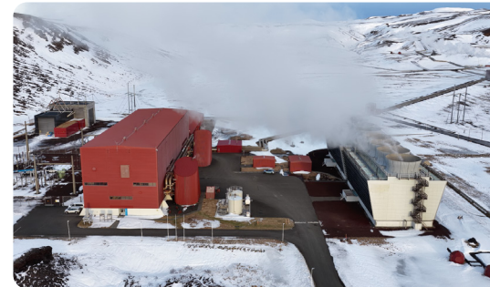
Kröflustöð, sem byggð var á áttunda áratugnum á tíma Kröfluelda, hefur verið í rekstri hjá Landsvirkjun í tæp 50 ár.
