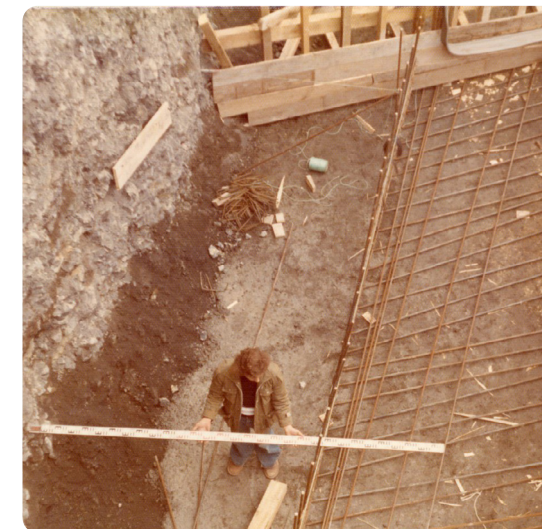
Framkvæmdir við Sigöldu í júlí 1976.
