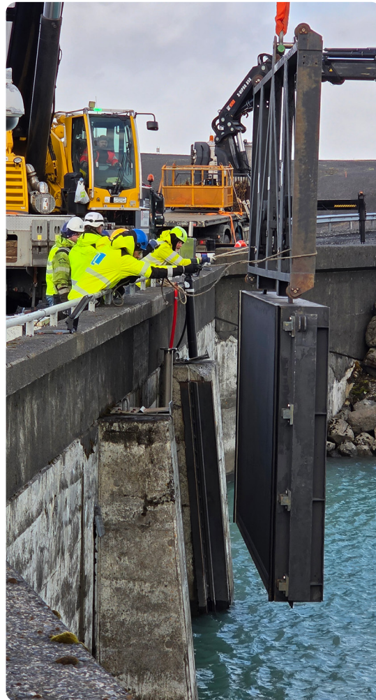
Vinnulokur settar niður í Þórislokum.
